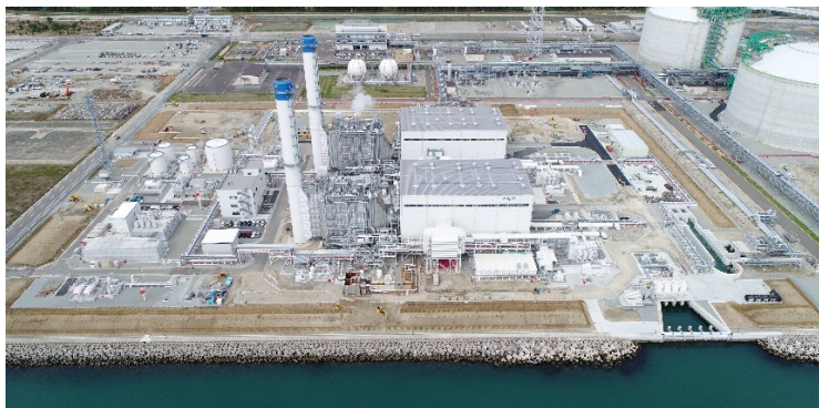
発電所全景 (右～奥は JAPEX 相馬 LNG 基地)
