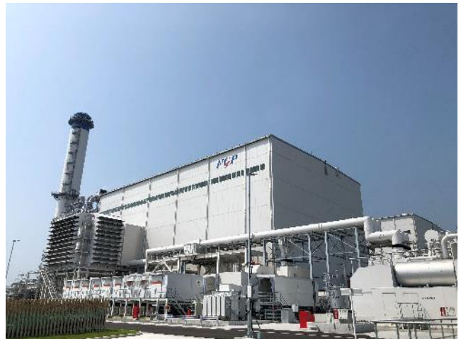
発電所地上から (手前が2号機、右奥が1号機)
